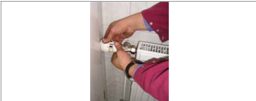
Abbildung 8 (N14) Der Thermostatkopf des vorhandenen Ventils wird abgenommen und das Ventil ausgebaut, da es nicht voreinstellbar ist
