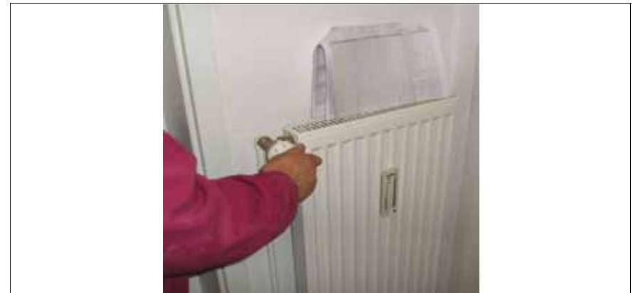
Abbildung 10 (N16) Aufsetzen des Kopfes auf das Ventil, nachdem der berechnete Voreinstellwert am Ventil eingestellt wurde
