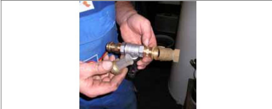
Abbildung 11 (N17) Filterunterteil und Filterelement vor dem Einbau
